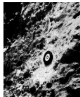
Señal empotrada en la Roca de Fundación
